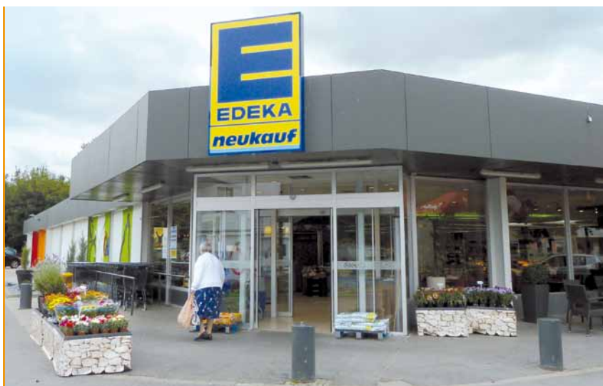
EDEKA Otto, Markt Bad Oeynhausen, nach dem Umbau
