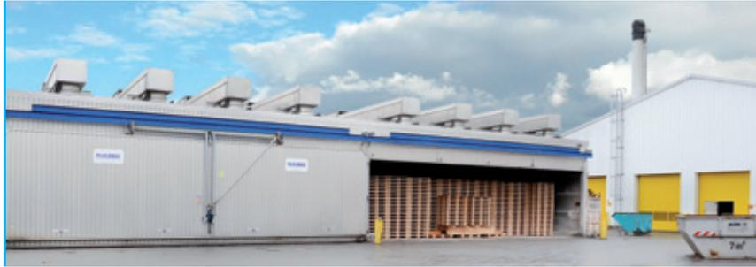
Trockenkammern für die produzierten Paletten
