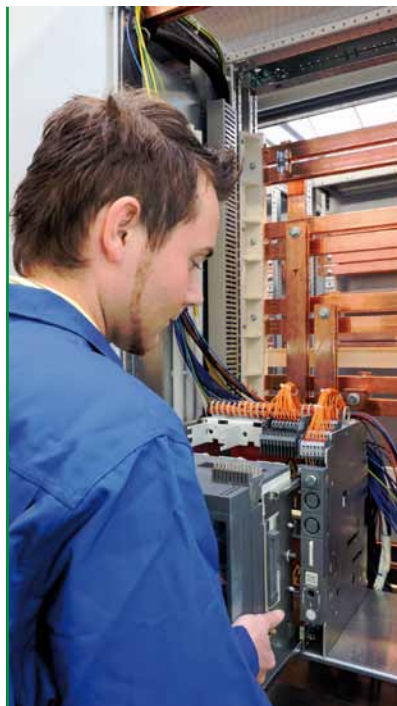
Montage einer Schaltanlage
